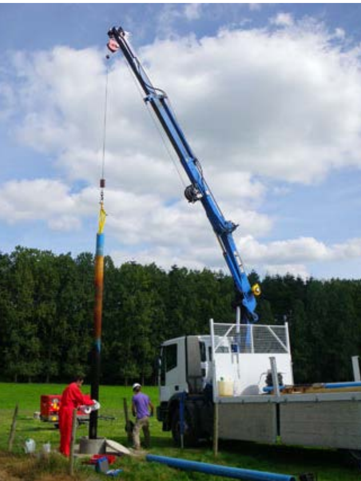
Un forage à la recherche d'eau souterraine © BRGM
