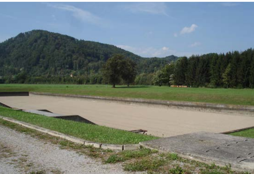
Bassin d'infiltration en Autriche, projet AquaNES © (AquaNES)
